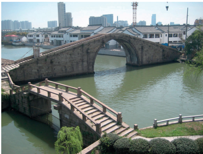
Figura 4. – Suzhou: il ponte Wumen. (Foto S. Piastra, 2013).
