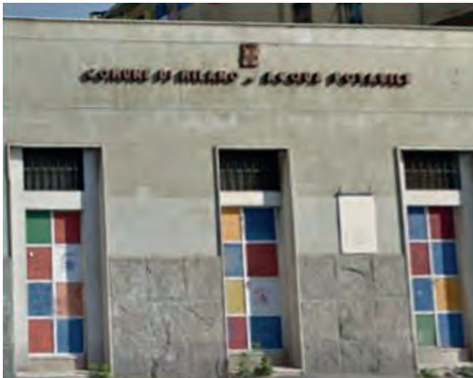
Figura 1. – Via Giambellino, Acqua Potabile.
